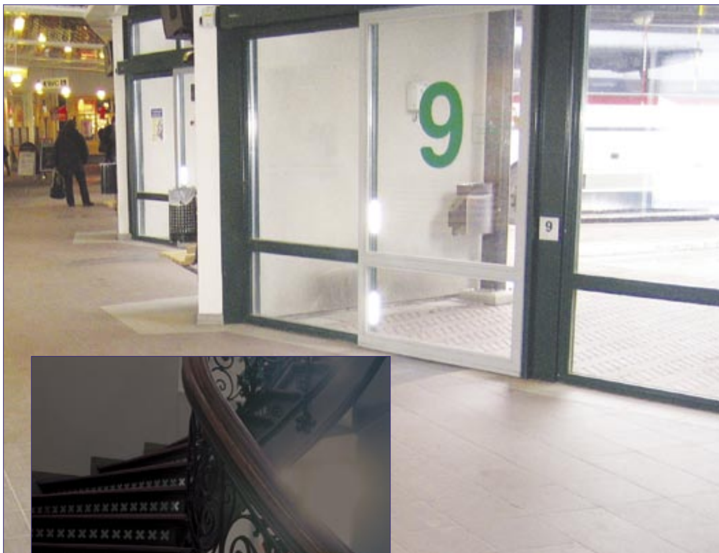
Figur 15 Hindrer sammenstøt: Markører på store glassflater hindrer uhell og gjør det lettere å orientere seg.
