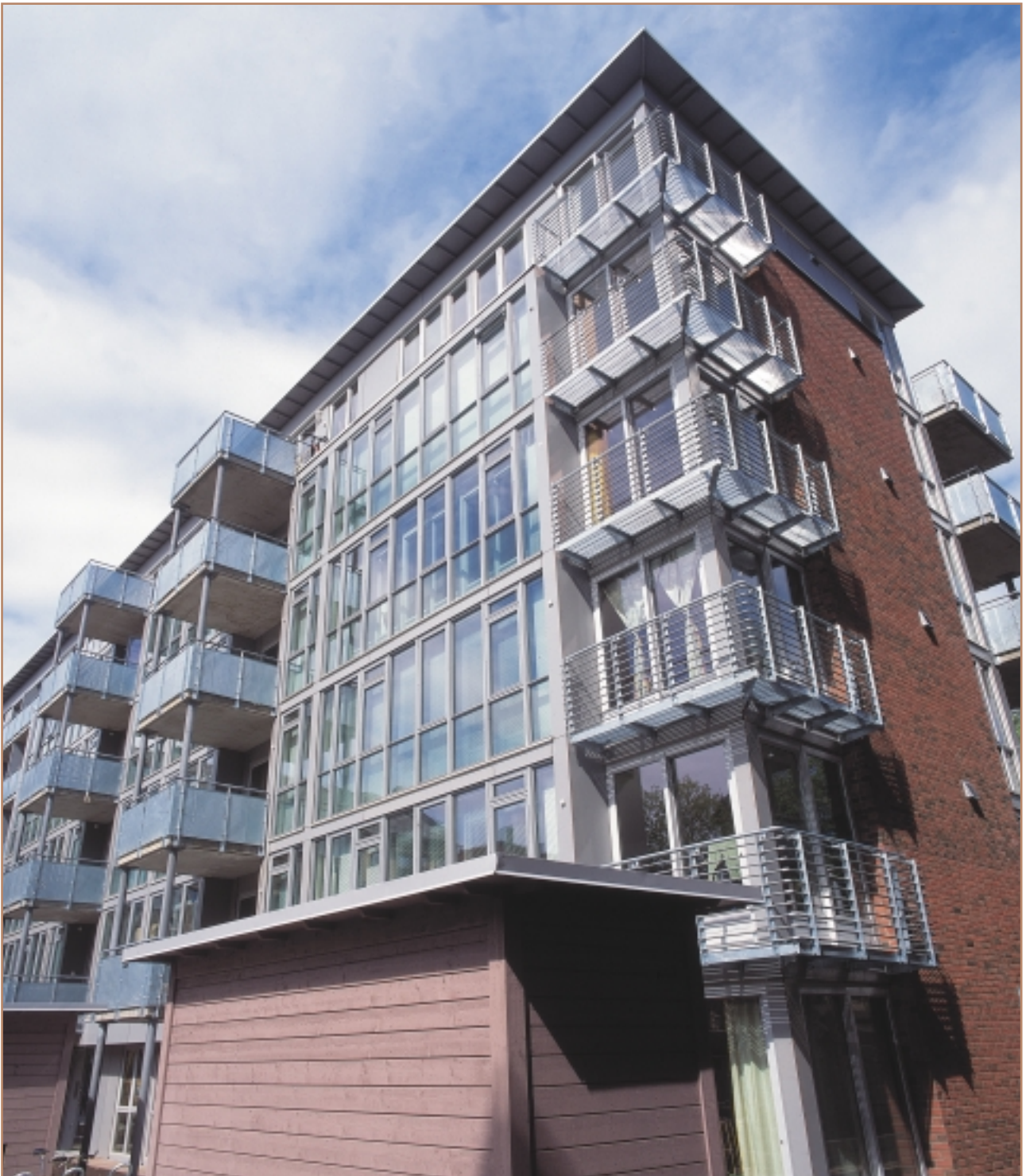
Klosterenga økologiboliger i Oslo. Ansvarlige: Boligbyggelaget USBL, entreprenør: Veidekke AS, arkitektkontorene Arkitektskap AS og GASA AS. Foto: Veidekke AS.
