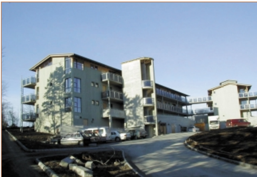
Bustadområdet Gauselbakken Syd utanfor Stavanger. Byggherre er Stavanger boligbyggelag. Arkitekt: Signatur arkitekter AS. Foto: Erlend Løvstakken.
