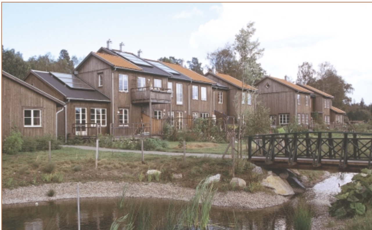
Bustadområdet Understeshöyden i Sverige med vass-system for reinsing av gråvatn. Arkitekt: HSB Riksförbunde, Stockholm. Arkitekt SAR: Bengt Bilén.
