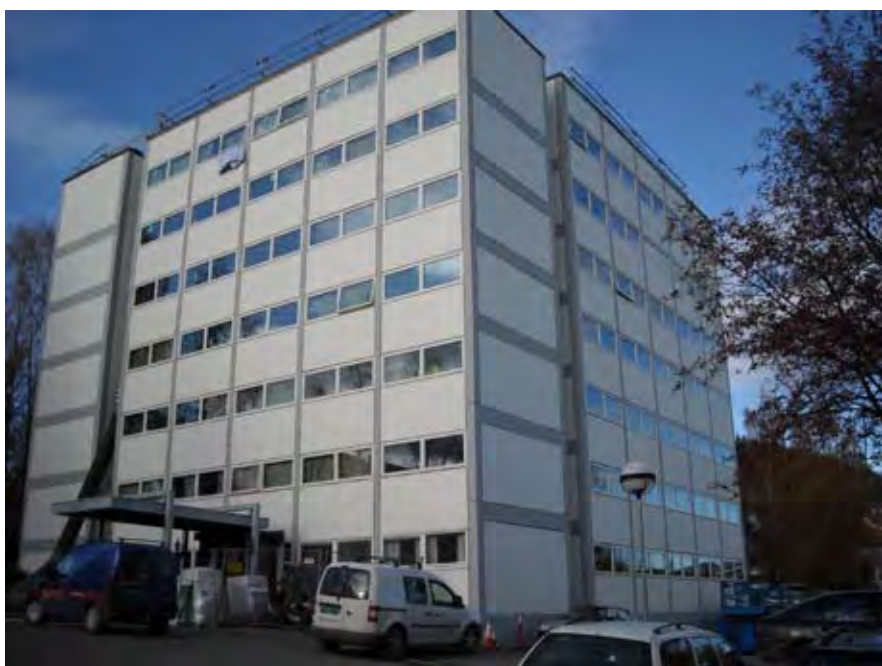
Ny fasade med nye energivinduer. Foto:Husbanken/Terje Høgmo
