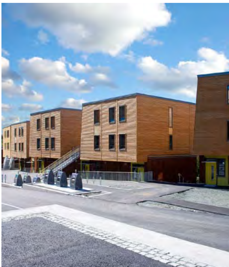
Bilde under: Viser uteplass og søppelanlegg. Foto SiT/Ståle Eriksen
