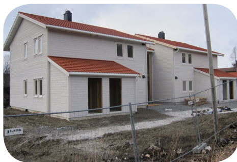
Realiserte boliger i samarbeid med boligbyggerlag Foto: Sørfold kommune
