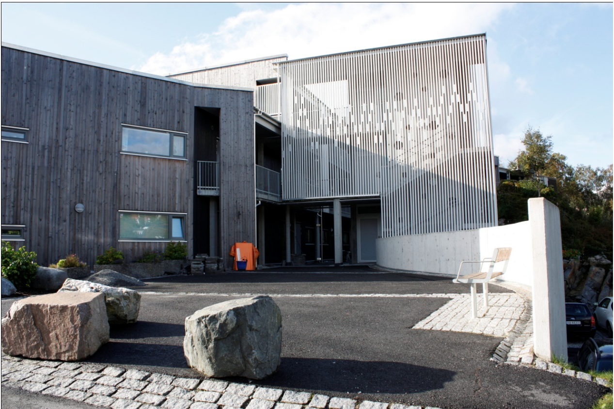
Fra inngangspartiet på Tertnes Premium med hvilebenk. Trapperommet med heis er godt synlig. Store k mpesteiner hindrer biler, men ogs  synshemmede. Det er br tt overgang mellom fortau og g rdsplassen.
