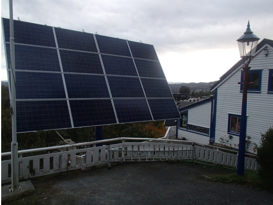
Foto: Arne Nakling. 2-akse stativ med solceller for å følge solens bevegelser i privat hjem i Bergen. Montert på dugnad av eier og frivillige.
