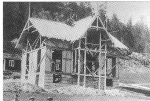
Reisverk erstattet lafteteknikken rundt 1860, samtidig som Sveitserstilen kommer til Norge. Dampsaga, til erstatning for vannkraft, og høvelmaskiner muliggjorde denne teknikken. "Tungt" bindingsverk av 4" x 4" med 2 x 2 lag panel og papp kom rundt 1920 og ble erstattet av lett bindingsverk rundt 1950.
