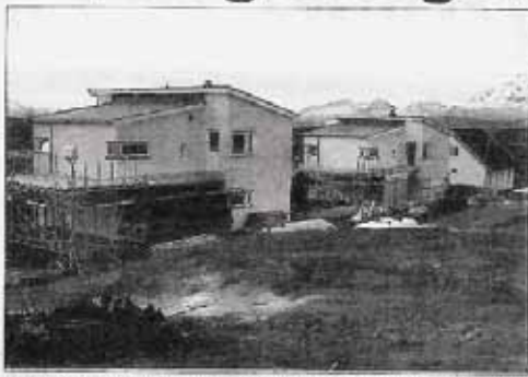
Arbeidet. Det er for tiden aktiv bygging i deler av Hamarøy som på mange måter kan beskrives som prekær boligproblematikk. På Oppveid får kommunen opplyst om nye boliger som snart er innflyttingsklare. Foto: Kjært & Olsen
