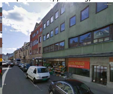
Forretning/kontor; Wænegården (Fjernvarme oppvarming og elektrisitet for varmt vann)
