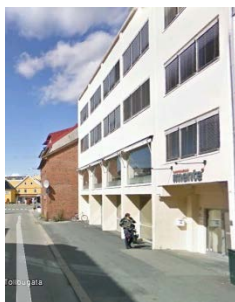
Forretning/kontor; Tollbugata 27 (Tilknyttet fjernvarme)
