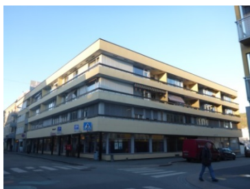
Bedrift og boliger; Tollbugata 13 (Tilknyttet fjernvarme)
