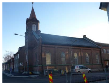
Kirke; Tordenskioldsgate 102 (Elektrisk oppvarming)
