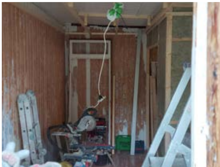
Bilde fra oppussing i Ormsundveien 12
