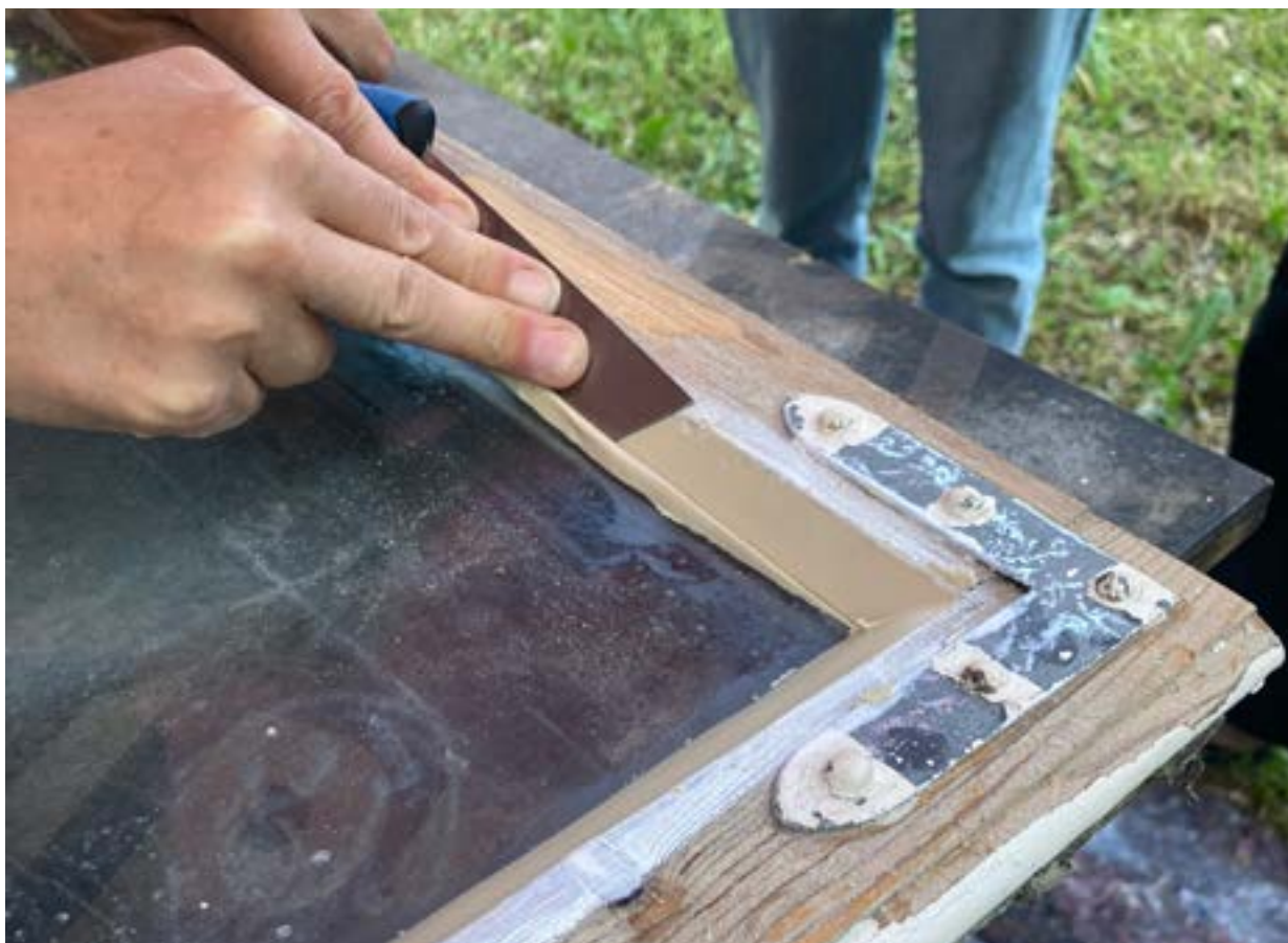
Bilde 1. Vinduskarm for rehabilitering. Her skal den skrapes for gammel maling, males m linolje maling og kittes om. Glassene skal byttes.
