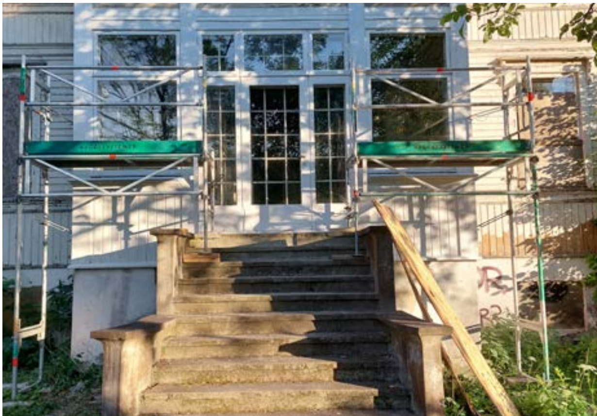
Bilde tatt etter restaurering av vinduer i 1 etasje. Ormsundveien 12.
