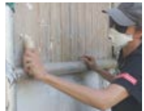
Bilde 3. Arbeid på fasade i Ormsundveien 12
