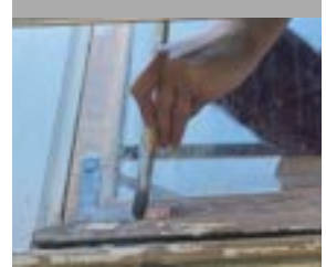
Bilde 2. Restaurering av vinduer i Ormsundveien 12.
