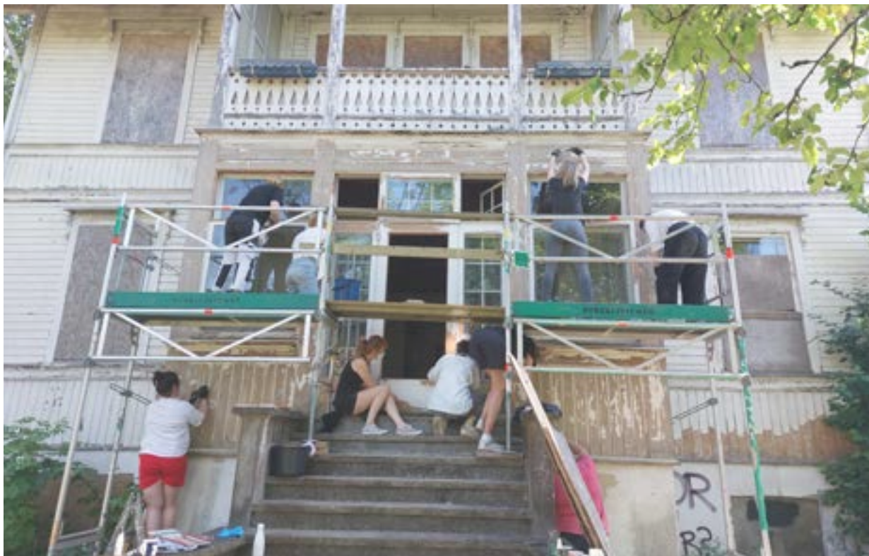
Bilde fra kurs i vindusrehabilitering
